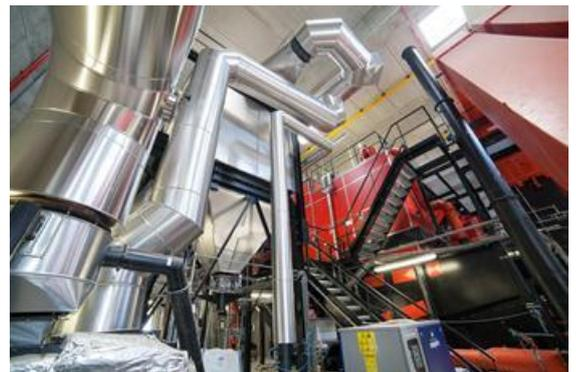
Les fumées en sortie des dépoussiéreurs passent dans des filtres à manches. Ces filtres à manches piègent les particules les plus fines. Celles-ci sont évacuées dans un « big bag ».
